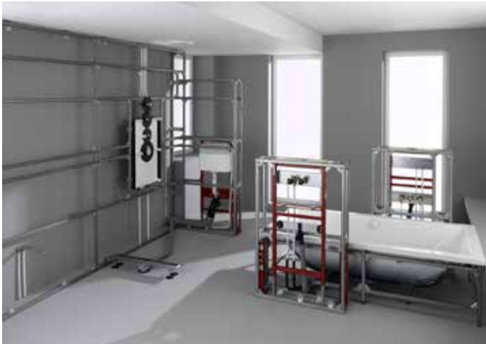
Sanitärwände mit TECEprofil – vorher
