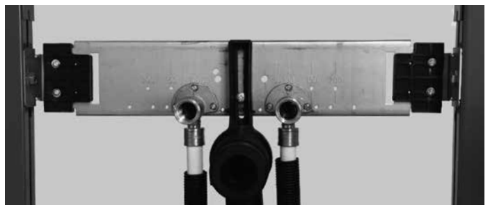
Schallentkopplung der Traverse vom Modulrahmen
