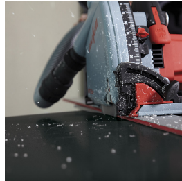
3. Platten zuschneiden, entgraten
