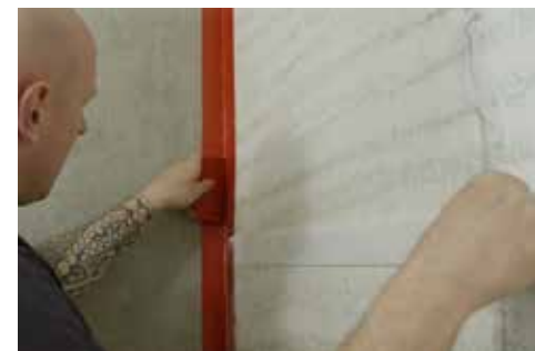
3. Eckdichtbänder anbringen
