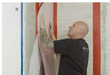
4. Dichtbahnen anbringen
