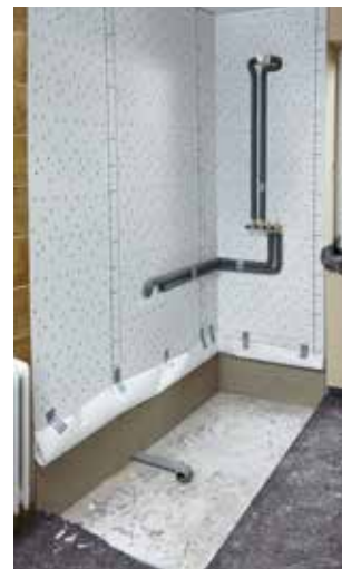
4. Leitungen installieren ggf. versetzen
