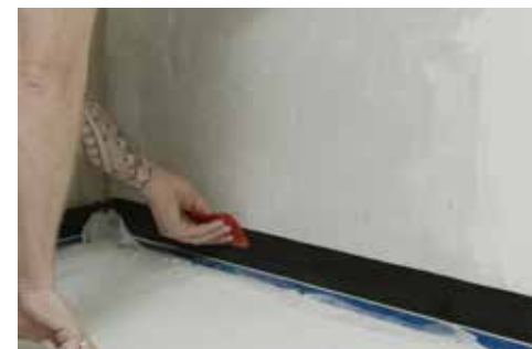
1. Wannendichtband verkleben
