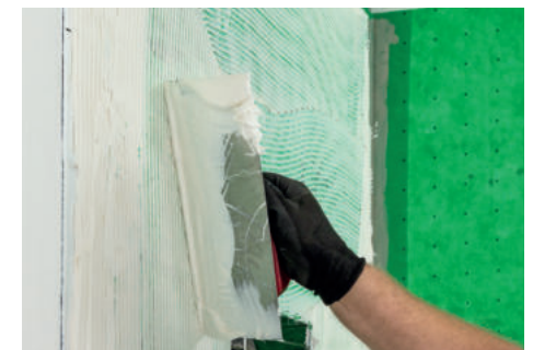
Kleber flächig verteilen
