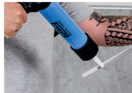
Silikonieren der Profilflanken
