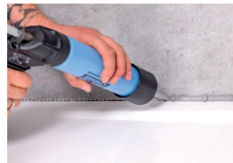
Zur Wand hin mit Silikon abdichten
