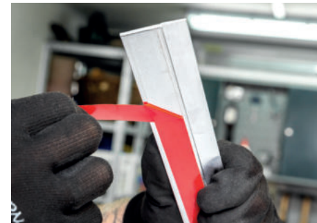
Klebeband-Schutzfolie abziehen
