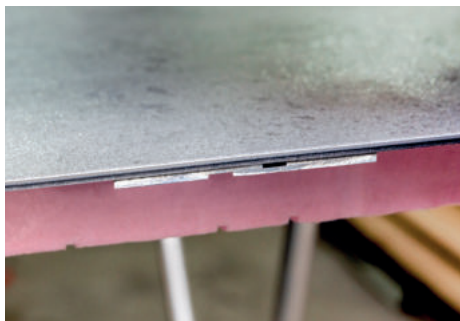
Nahezu unsichtbarer Plattenstoß
